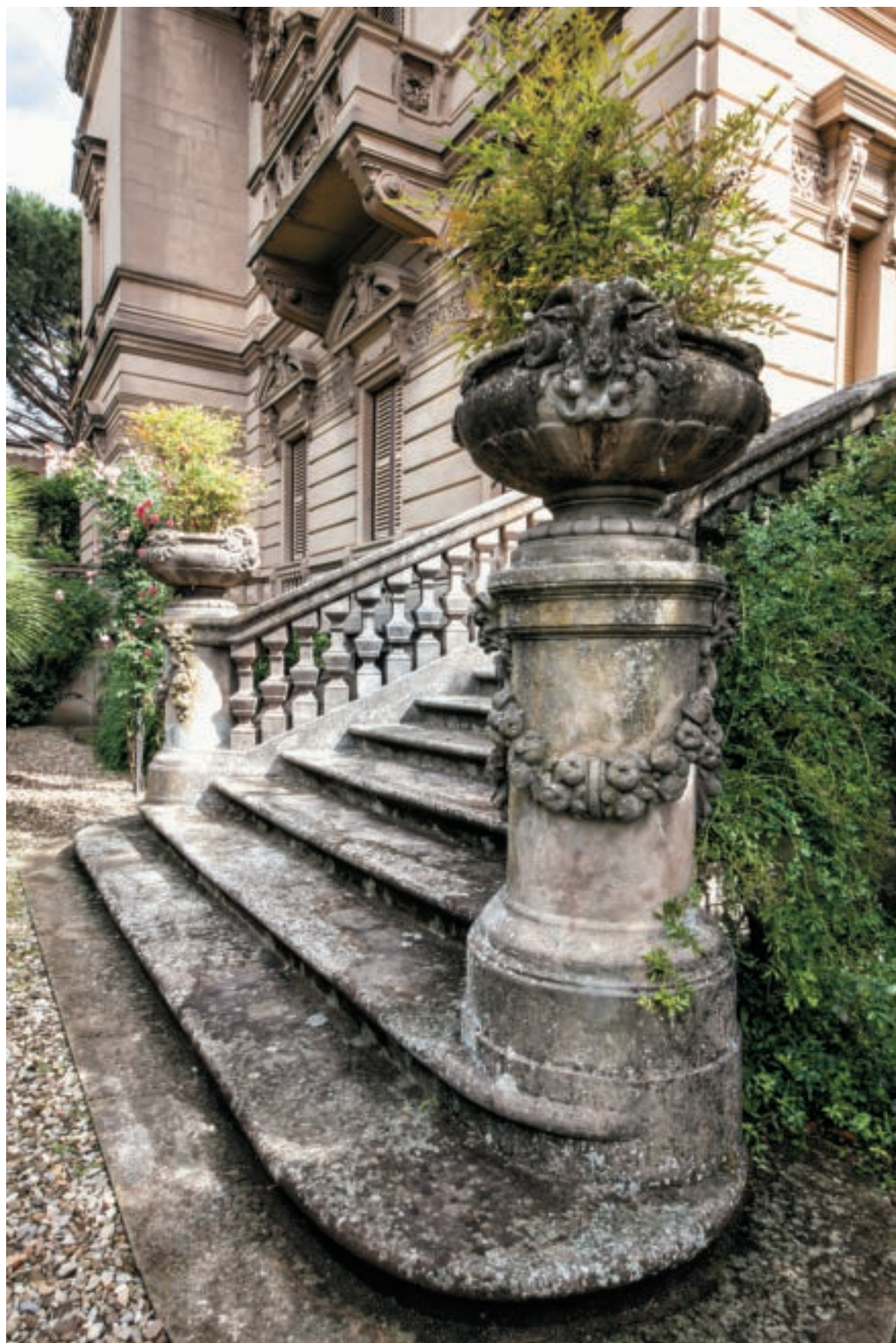
Vista della scala sul retro
