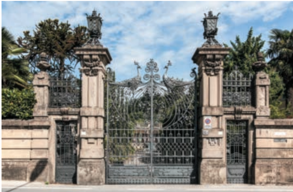
Cancello d'ingresso principale in ferro battuto delle Officine Brunelli di Pistoia
