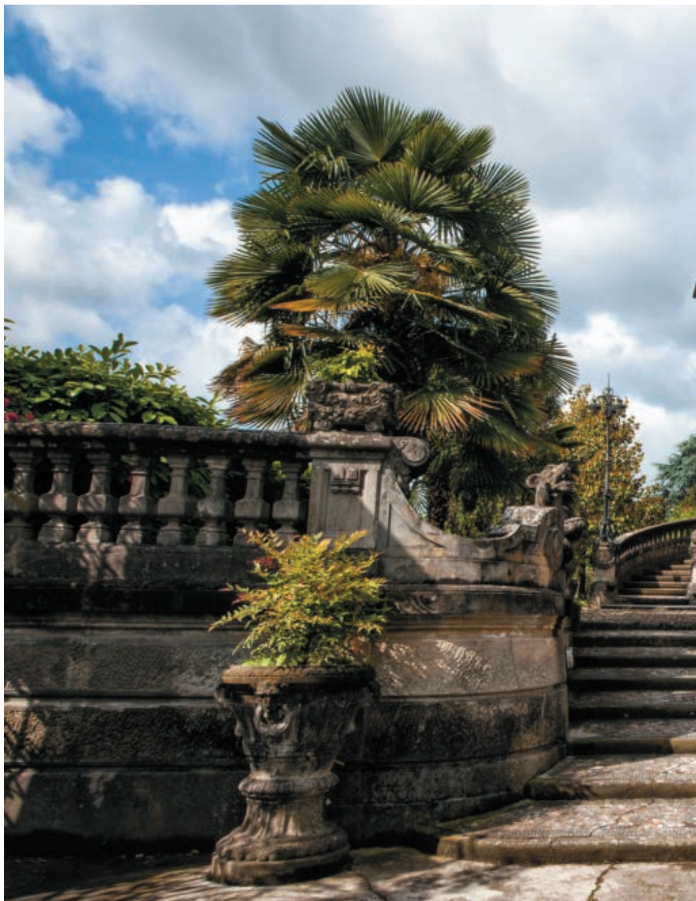
Ingresso principale di Villa Masini
