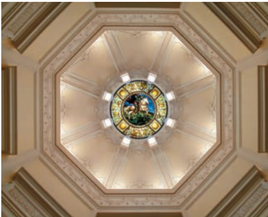
Vestibolo centrale ottagonale al primo piano, veduta della copertura con il 'velario' vitreo sommitale
