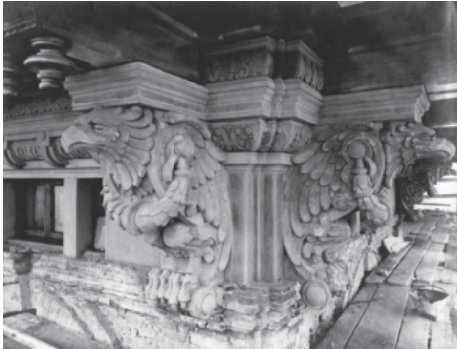
L. Brandaglia e aiuti, angolo sud-est della Villa, particolare del fregio scultoreo (Archivio Vestri, Comune di Montevarchi)
