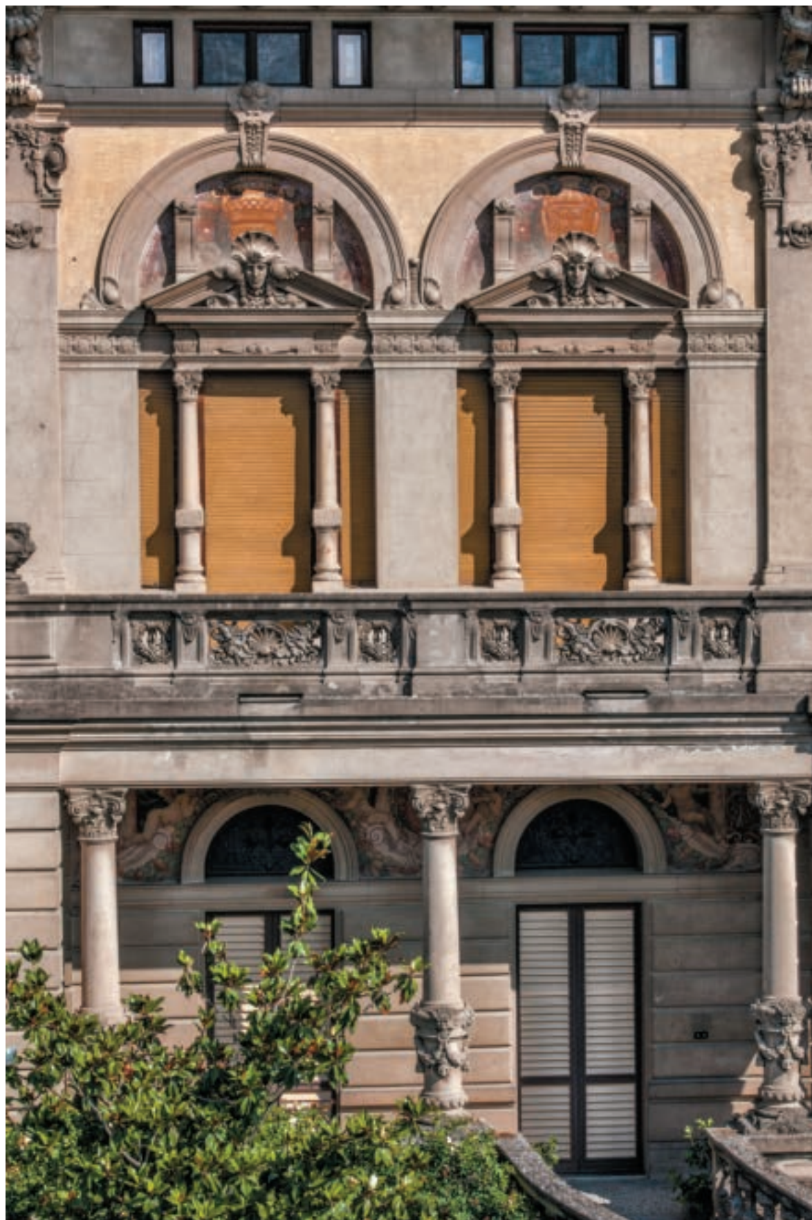
Particolari della facciata
