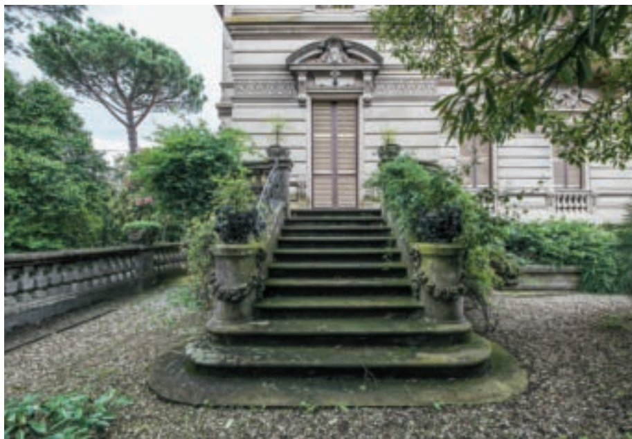
Scala di accesso al giardino sopraelevato dalla torre-belvedere
