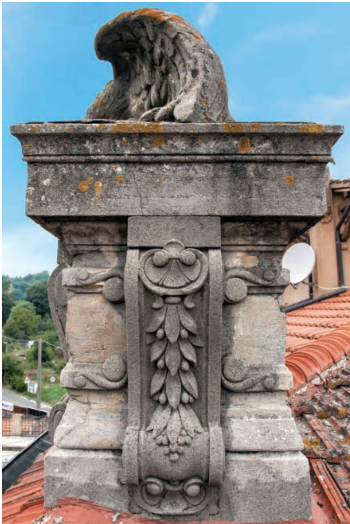
Particolare della Colombaia della Rimessa
