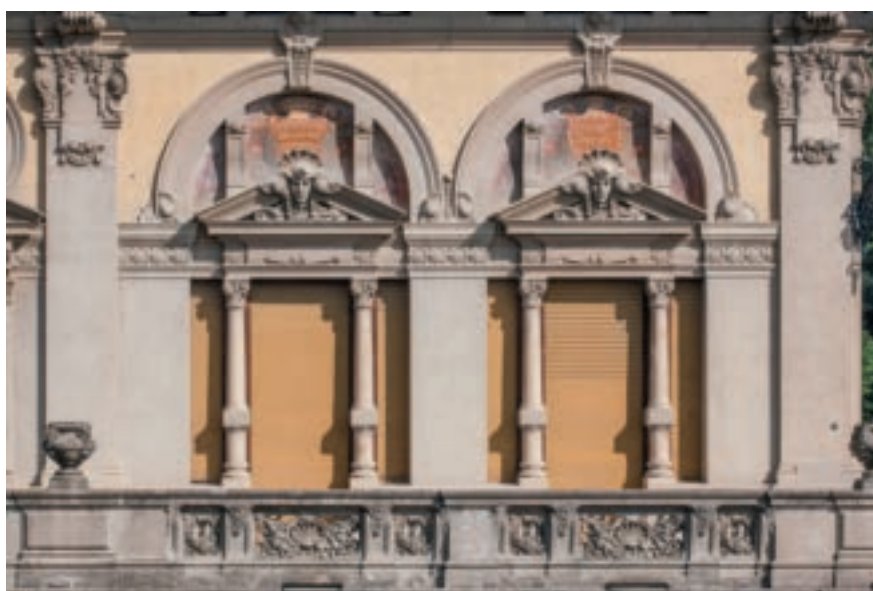
Fronte principale della Villa, aperture del primo piano sopra la loggia
